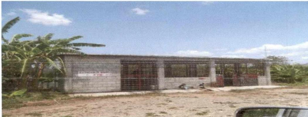
Edificación de estación de Bombeo, construida en sistema Porticado de Losa, Vigas y Columnas de hormigón armado y muro de cierre de bloques de 6", con vista posterior del reservorio de agua de 2.0 millones de galones de agua.
